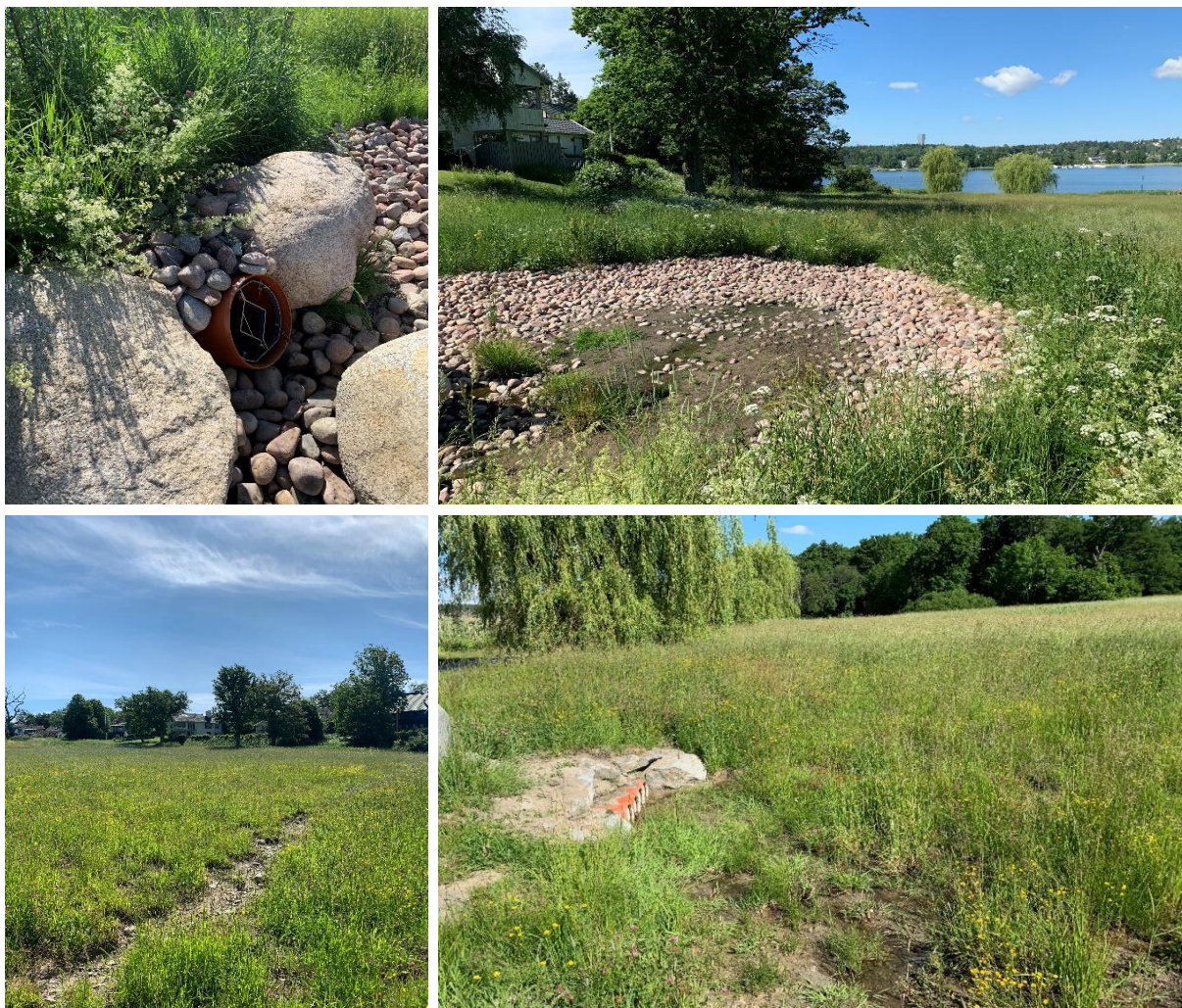
Figur 26. Vid Sättra ängar i Danderyd har en dagvattenledning öppnats upp. Vattnet tillåts nu sila över en större grönyta innan utsläpp till Edsviken (Foto: Bjerking).
